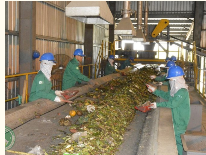
Nhà máy xử lý phân mùn Compost tại LKHXLCTR Tràng Cát
